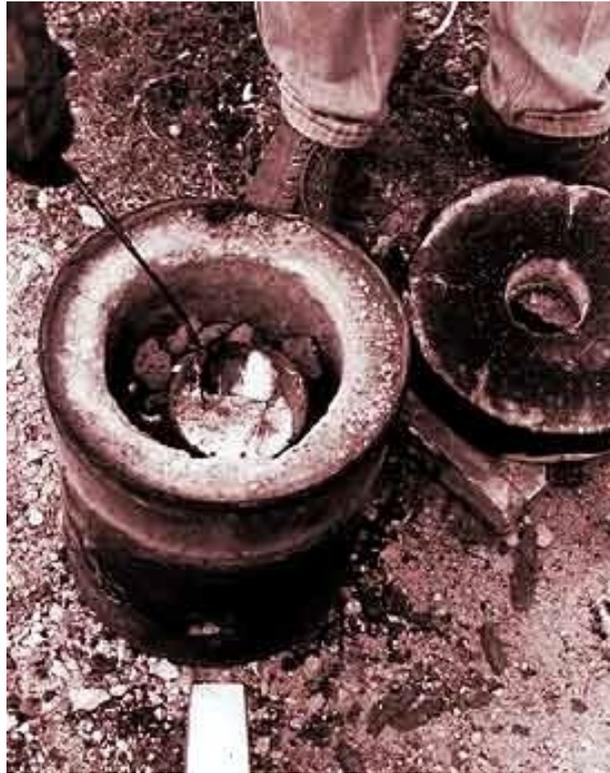
ジンジャリーは最初に簡単な鋳物工場を自宅の庭に作った。これは小さな5ガロン（約19リットル）のバケツに砂を詰めたものである。その中心には火の付いたバーベキュー用木炭をコーヒー豆の缶に入れて置いてある。缶の中には小さな陶器のるつぼがあり、そこに空き缶などアルミのスクラップを入れる。この粗末な溶解炉にファンで空気を送り込み、炭をよく燃やして高温にして、アルミを溶かす。湿った砂を彫り込んで所望の品物の型を作り、そこに溶けたアルミを流し込む。その鋳物が冷えれば金属プレートができていて、それが自家製旋盤の重要部品になる。この粗い部品を手工具で仕上げ加工する。一つだけ「ごまかし」があって、中古の電動モーターを使っている。ただし、風力や水力を使う方法もありうることは容易に想像できる。
